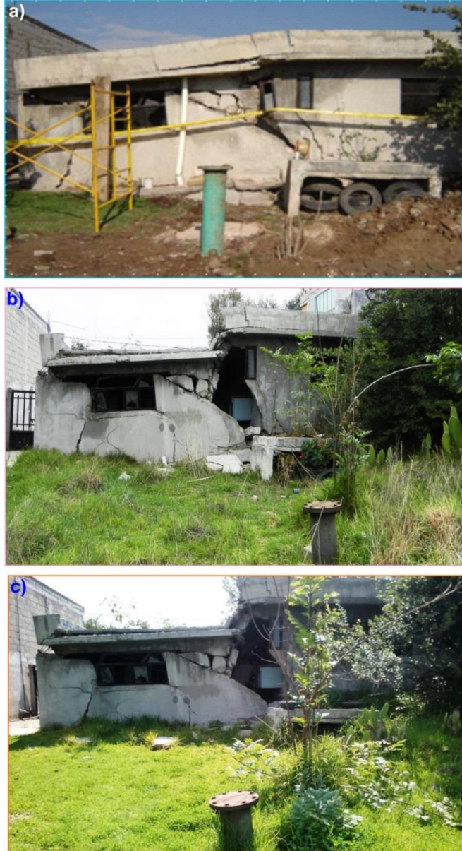
Figura 2.6. Evolución del fracturamiento en un inmueble afectado por subsidencia localizado en el municipio de San Pedro Tololtepec. a) Mayo de 2006, b) diciembre de 2014, c) 2016. Llama la atención la manera en que la habitación descende, en la imagen (c) se aprecia prácticamente horizontal la porción izquierda, mientras que en la (a) se observa un ángulo en dirección SW, siendo la esquina izquierda la que presentaba mayor desplazamiento.
